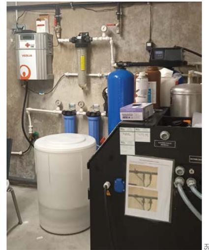
Au sous-sol, un local technique permet la récupération des effluents dans une cuve spécifique et accueille le système de secours électrique - indépendant du réseau - qui permet, en cas de panne, de finir un cycle d'analyse et d'arrêter les automates de manière contrôlée.
